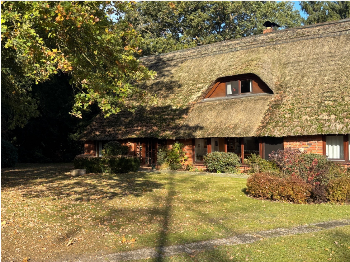
Südseite des Hauses und Garten
