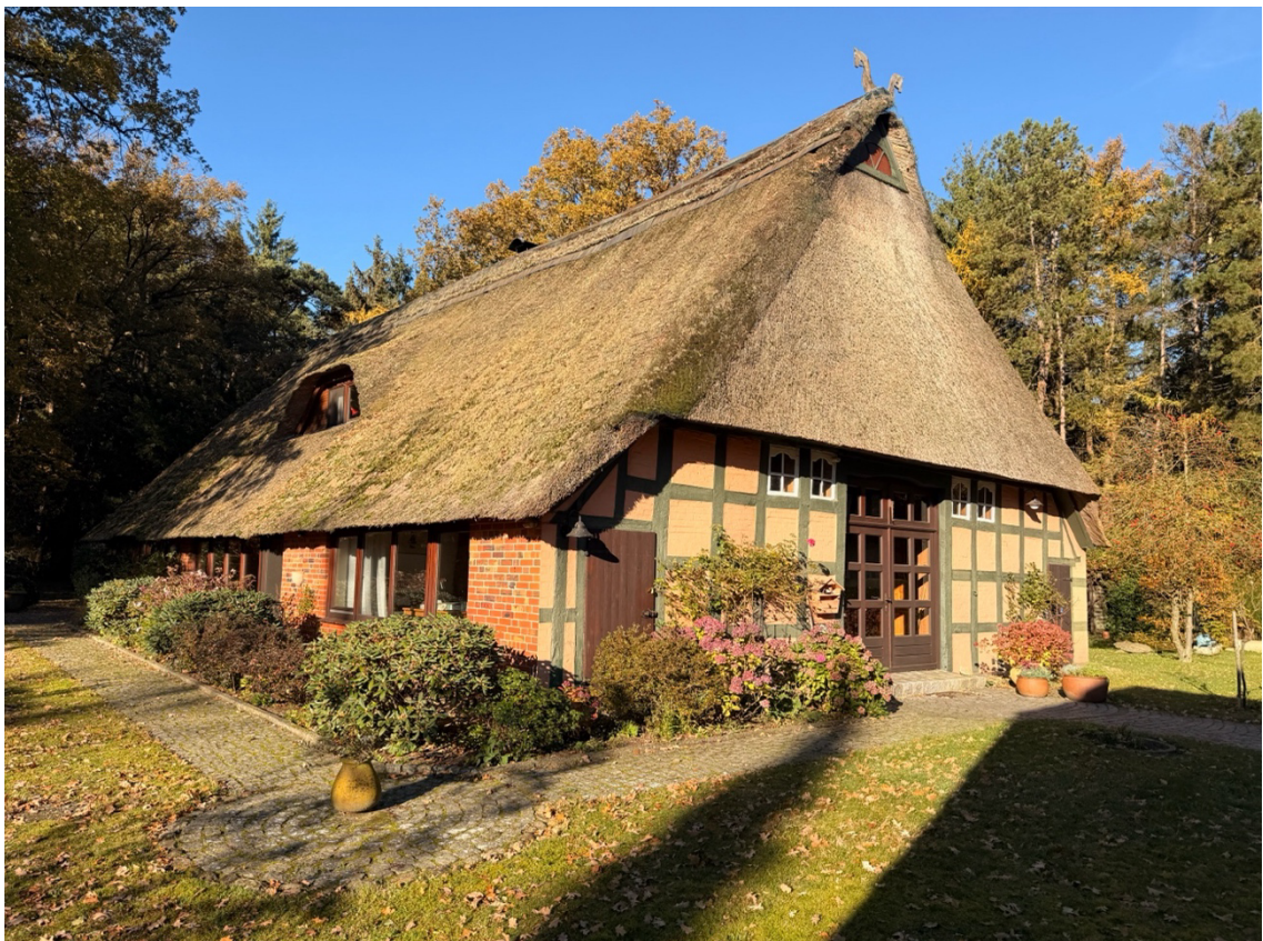
Historisches Wohnhaus mit Reetdach
