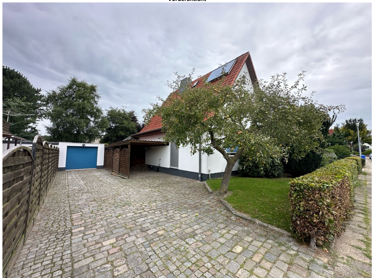
Vorderansicht mit Blick auf die Garage und das Carport
